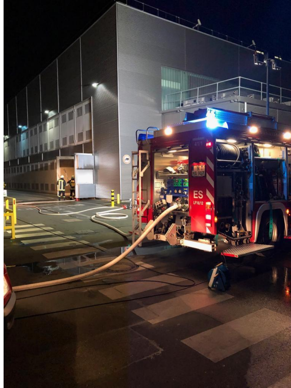
Brand einer Schaltanlage.
